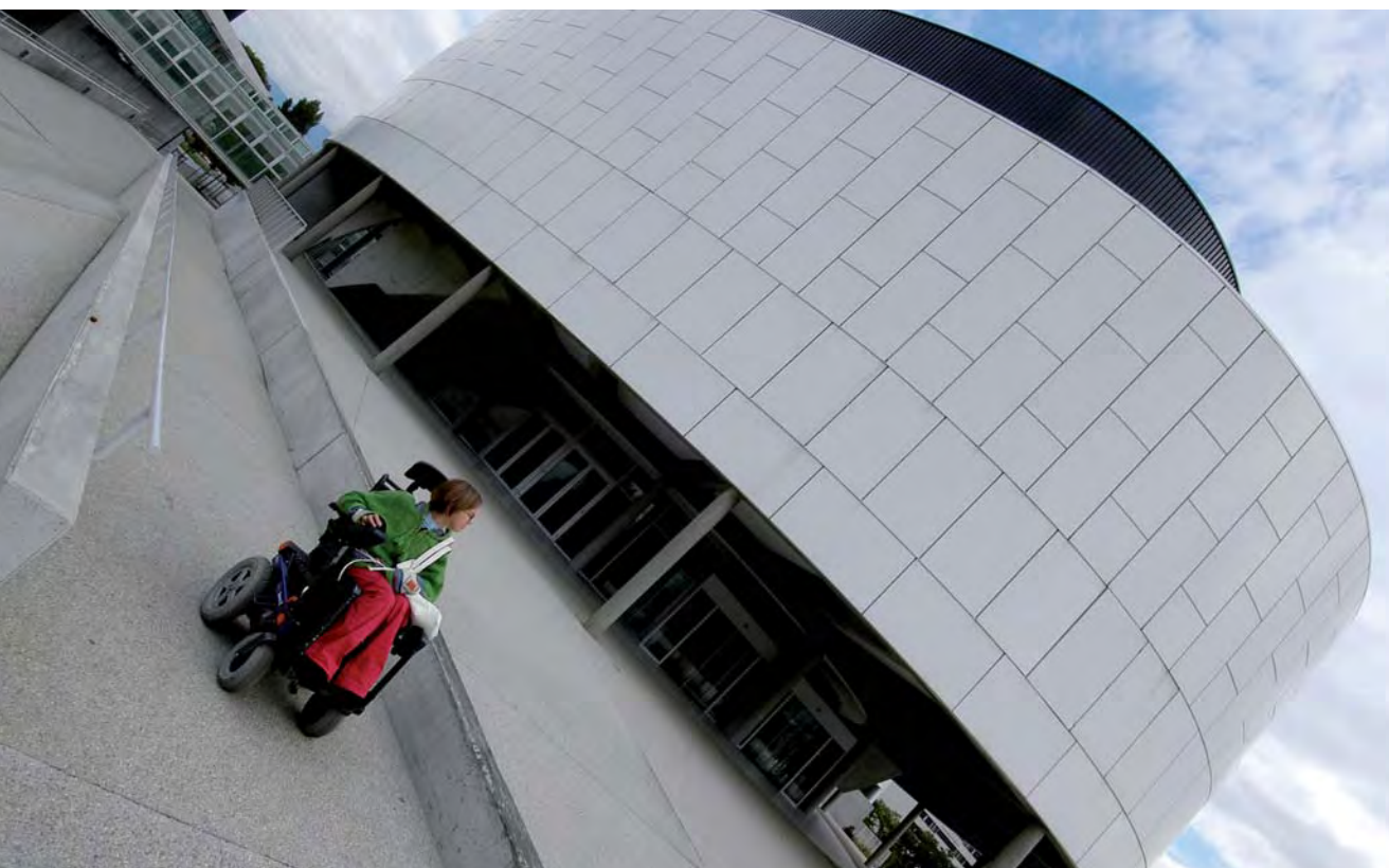
La rampe d'accès de la Maison de la culture de Grenoble.
